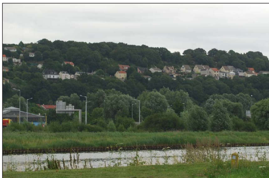
Le canal de Tancarville au Havre : des berges en palplanches métalliques et une absence totale de végétation d'accompagnement.
