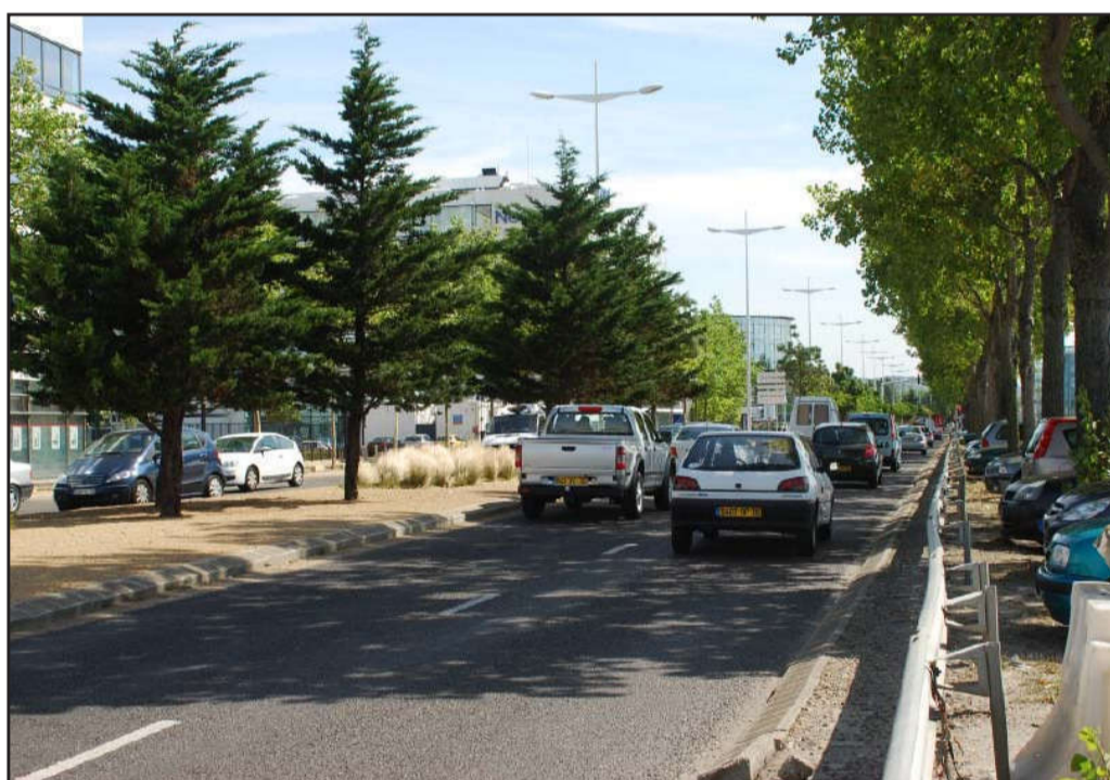
L'entrée de la RD 6015 dans le Havre, un axe routier récemment aménagé avec toutefois des portions peu valorisantes. (2009 - commune du Havre)
