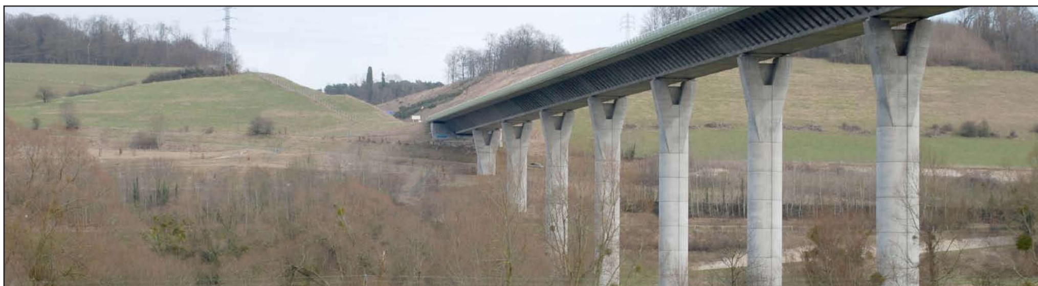
Le franchissement de la vallée de la Bresle par l'A 29 : une infrastructure qui s'affranchit du relief, un ouvrage «transparent», mais des coteaux fortement entaillés. (2010 - commune d'Aumale)
