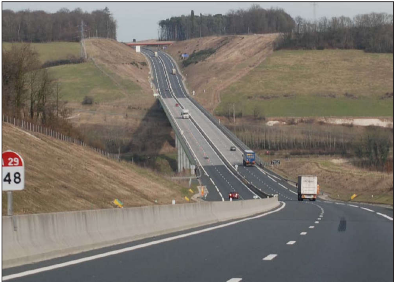
Une végétalisation des talus permettrait de mieux «cicatriser» l'entaille de l'autoroute dans les coteaux.
