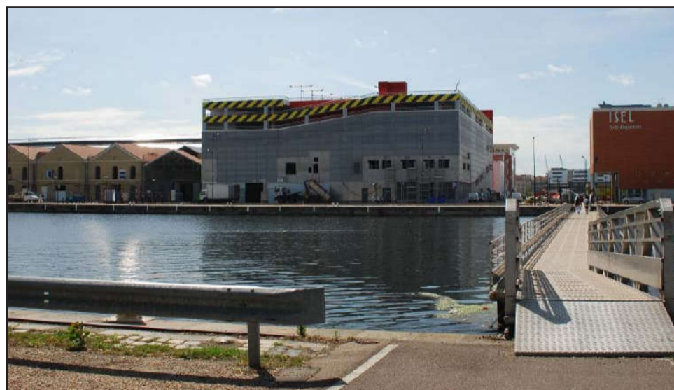
Réhabilitation de vieux bâtiments et construction hi-tech donnant une nouvelle image à ces quartiers de villes. (2009 - commune du Havre)
