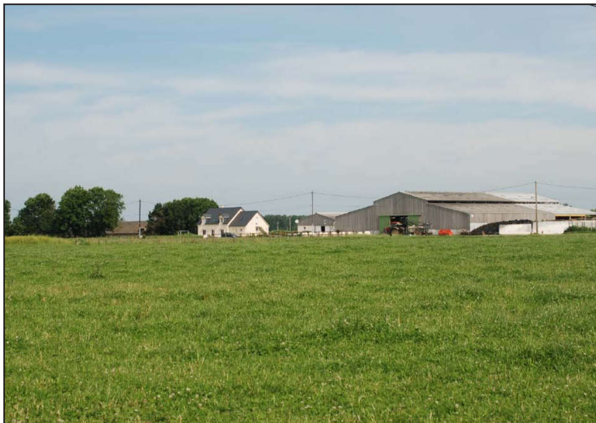
Hangar agricole récent situé à l'extérieur du clos-masure. Il est par conséquent très visible depuis l'espace agricole. En revanche, son bardage en bois et sa volumétrie (toit à plusieurs pentes) lui donnent un caractère soigné.
