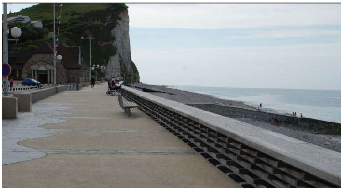
La digue réaménagée sur l'embouchure de la Durdent confère beaucoup plus d'espace aux piétons, mais conserve son aspect figé. (2009 - commune de Veulettes-sur-Mer)
