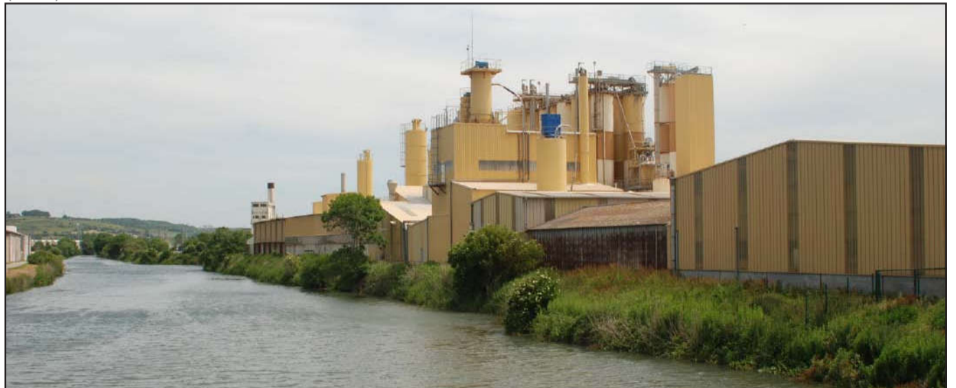
Site industriel du Tréport au coeur de la vallée. (2009)
