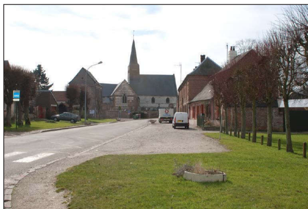
Village de Melleville : un caractère rural sobre avec des plantations et des trottoirs enherbés. (2009)
