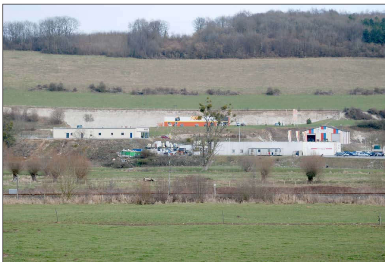
Zone d'activités implantée sur les pentes, bien trop en vue dans la vallée.
