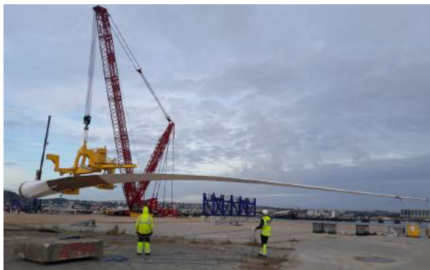
Essai de transfert de la plus grande pale du monde, l'Haliade X (107m), sur le quai lourd (15T/m 2 ) du port de Cherbourg ©Ports de normandie
