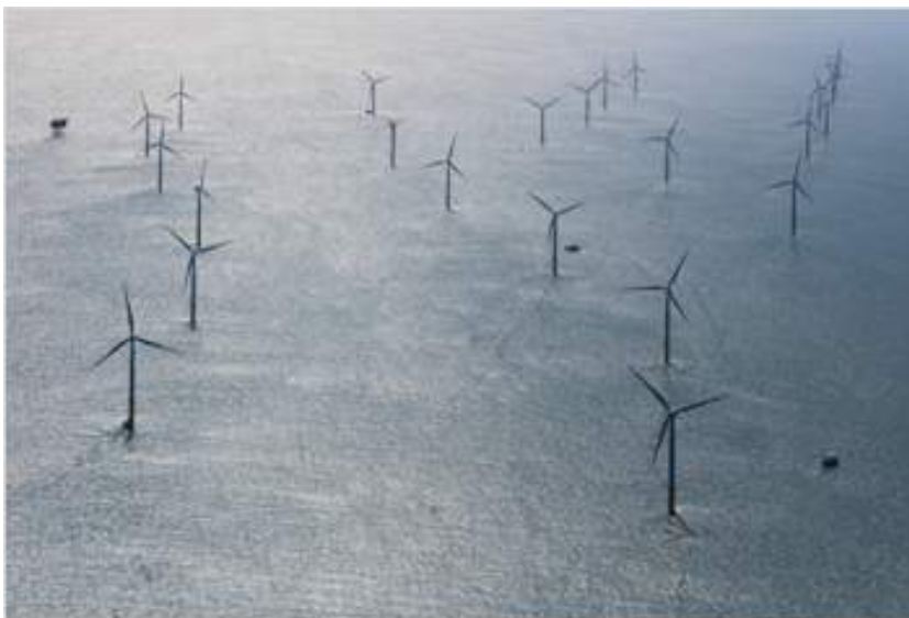
Parc éolien en mer de Butendiek © wpd AG
